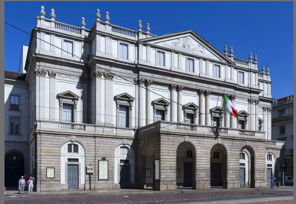
Edificio in stile Neoclassico Giuseppe Piermarini, Teatro alla Scala, 1776-1778, Milano
