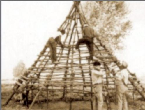
5/11 - La struttura del tetto viene completata con altri anelli
