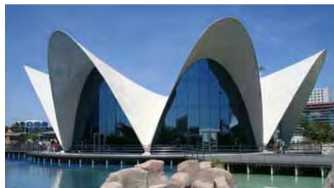
6 Santiago Calatrava, volta a paraboloidale iperbolico in uno degli edifici della Città delle Scienze e delle Arti, 2002. Valencia.
