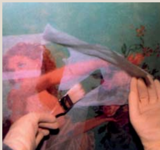
Applicazione di foglio di carta giapponese mediante pennello intriso di resina acrilica diluita.
