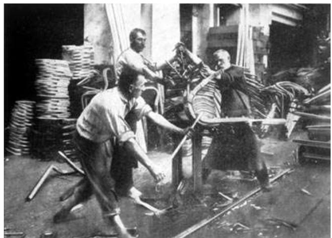
Piegatura dei listelli nella fabbrica Thonet (inizi del '900). I listelli estratti dall'autoclave, in cui hanno assorbito umidità, vengono piegati a forza nelle forme metalliche e fissati con morsetti, per poi essere essiccati nei forni.
