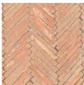
Opus spicatum. I mattoni messi di coltello con andamento a forma di spiga (spica) sono particolarmente adatti per pavimentazioni.
