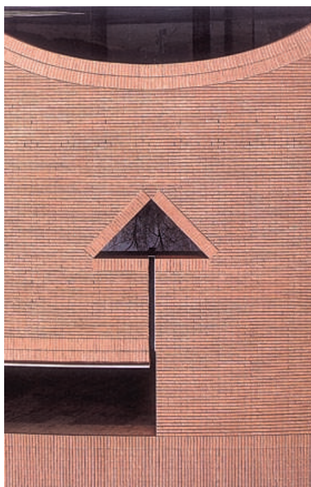
Villa a Bernareggio, Milano, di Mario Botta (2000). La marcata geometria della composizione architettonica acquista calore nel rivestimento in mattoni.
