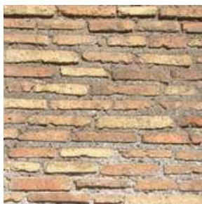
Opus latericium. Classica configurazione per muri resistenti e di aspetto particolarmente decoroso.
