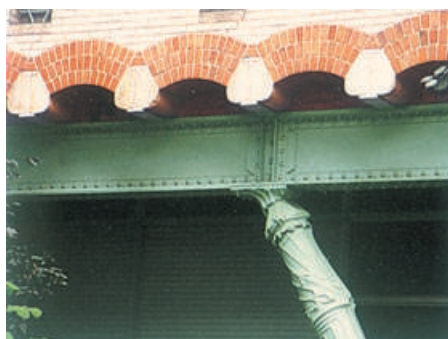
Collegio del sacro Cuore a Parigi di Hector Guimard (1900). Travi in ghisa di forma innovativa si coniugano in modo originale ai tradizionali voltini in mattoni.
