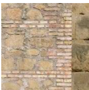
Opus mixtum. Adatta a murature con rinforzi angolari con incastri (ammorsature) in altri materiali più economici (tufo).
