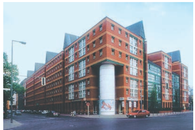
Complesso residenziale Wilhelmstrasse a Berlino di Aldo Rossi (1986 - 1988).
