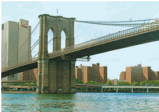
Ponte di Brooklyn, a New York di J. A. Roebling (1869 - 1883).
