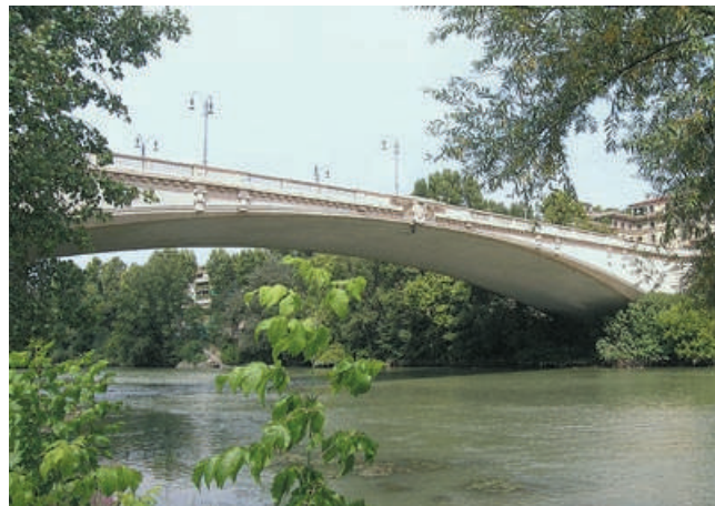
Ponte Risorgimento, a Roma, di F. Hennebique (1910).
