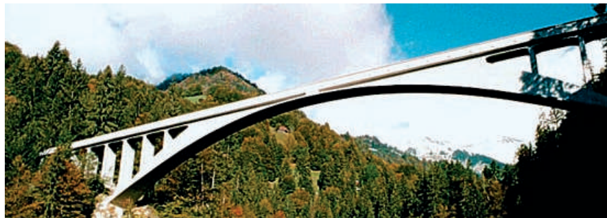
Ponte Salginatobel, in Svizzera, che con un elegante arco scavalca la gola sottostante a oltre 90 metri di altezza. Fu progettato nel 1929 da Robert Maillart, il grande ingegnere svizzero che rinnovò profondamente le forme nelle strutture in cemento armato.
