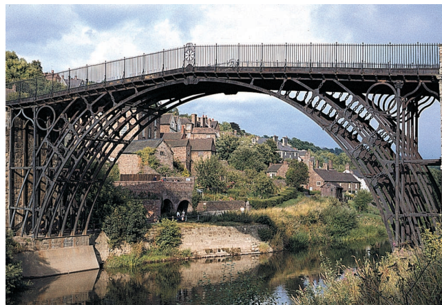
Iron Bridge a Coalbrookdale, Inghilterra, di A. Darby, J. Wilkinson e T. Pritchard (1775). Primo ponte in ghisa con arcata di forma semicircolare, che aprì la strada a sviluppi importantissimi nell'ingegneria delle strutture.
